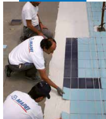
Assentamento de revestimento cerâmico sobre Mapelastic
