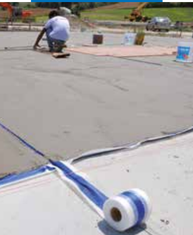
Impermeabilização de betonilhas com Mapelastic e Mapeband
