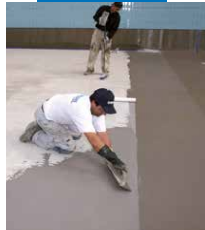
Impermeabilização de uma piscina com Mapelastic
